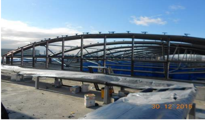
Şekil 5. ETFE Çatı İnşaatı
